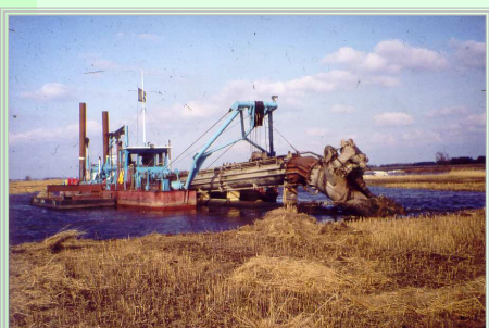
Die Seevergrößerung erfolgte mit schwerem Gerät: Der Spülbagger
