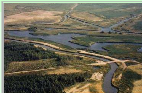
... kurz nach dem Ausbau
