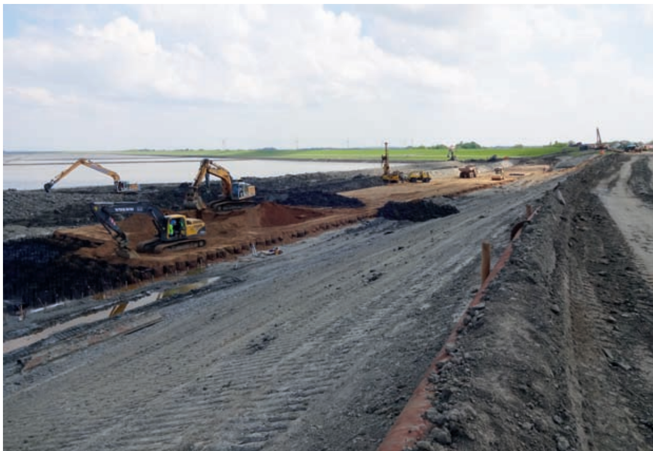
Abb. 13: Deichverstärkung Alter Koog Nordstrand (LKN)
