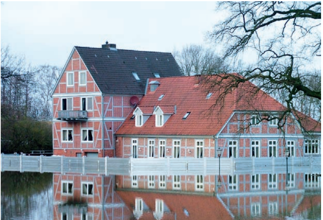
Abb. 15: Elbehochwasser 2011 - Objektschutz Palmschleuse Lauenburg (MELUR)
