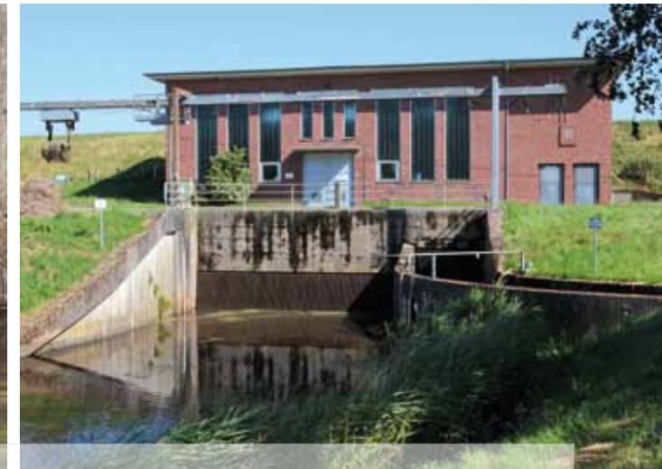
Im Schöpfwerk St. Annen wird das Wasser auf zwei Ebenen zugeführt.
